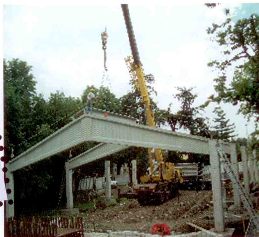
Il nuovo nido in costruzione
